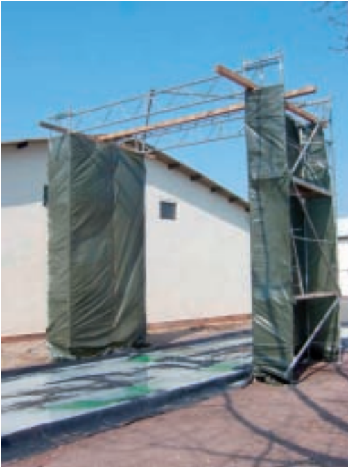
Abb. 5: Befahrbare Desinfektions- schleuse mit Verweh- schutz, wie sie 2006 im Fall der Vogelgrippe in Sachsen zur Anwendung kam (Foto: R. Steffler)
